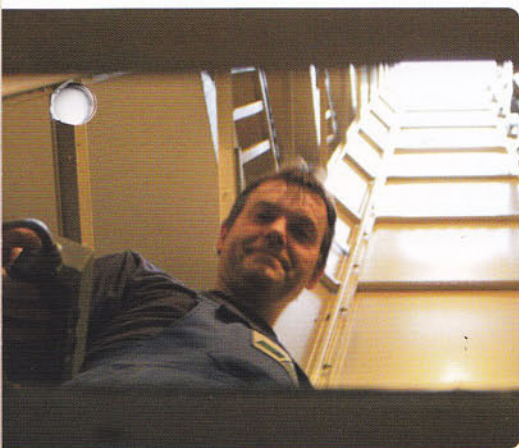
Herr Kleimann von der Firma ALKO bei der Montage der Aufzugsverglasung am fertigen Schachtgerüst
