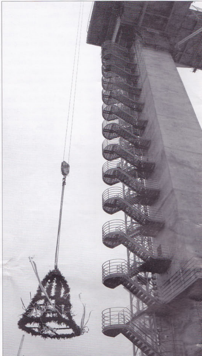
Richtfest für den Tower der Flugsicherung
