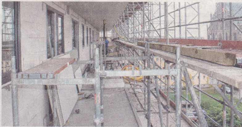
Nach der Demontage des Schutzdaches kommt das neue fünfte Geschoss zum Vorschein. Der Wohnraum in dieser Etage wird komplett behindertengerecht ausgebaut.
