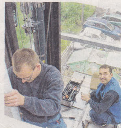
Heiko Zinc und Heiko Dauer (von links) von der ALKO Fördertechnik GmbH montieren die Aufzüge.
