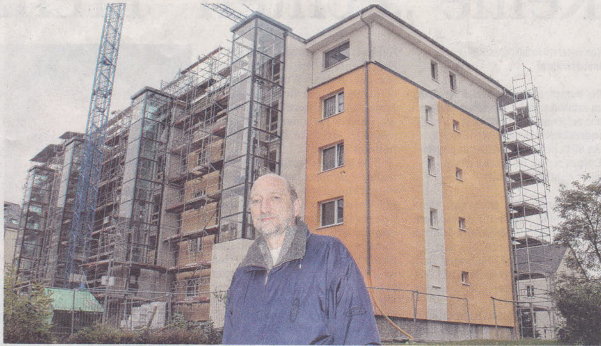
Hans-Peter Wolf, technischer Vorstand der Wohnungsgenossenschaft Prenzlau eG., ist zufrieden mit dem Baufortschritt am Wohnhaus Scharnstraße 15 bis 21. Dass sich hinter der wärmedämmten und farblich ansprechend gestalteten Fassade ein WBS-70-Plattenbau „versteckt“, ist kaum zu erahnen.
